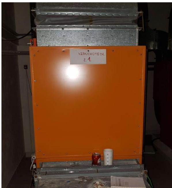
Obr. 22: vnitřní část split jednotky
