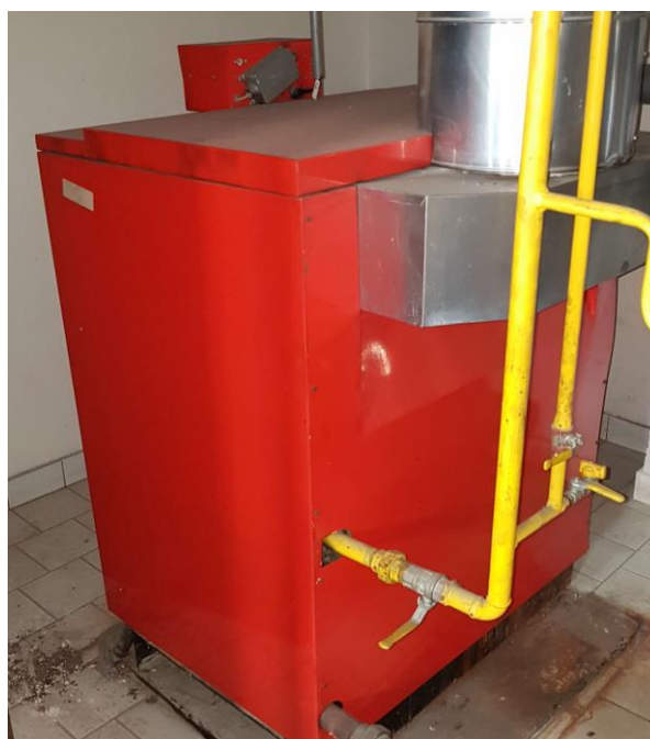
Obr. 17: Kotel na vytápění 2
